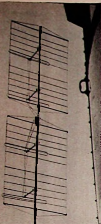
Diese Kathrein-Antennenanlage auf dem 45 m hohen Ausstellungsturm versorgte über mehrere Antennenverstärker und ein umfangreiches Kabelnetz mehr als 200 Geräte mit Empfangsspannung
